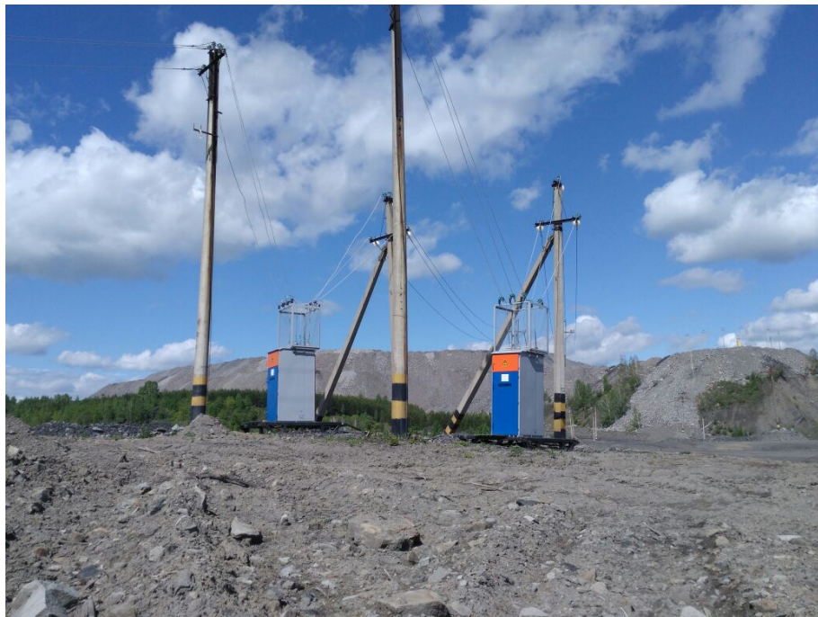
Рисунок 7 – Эксплуатация ячеек ЯКНО
